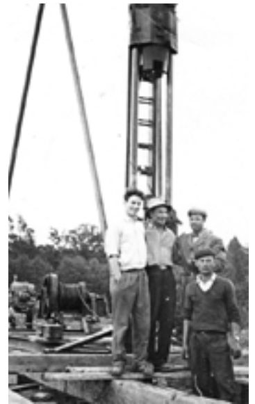
Zupanc, Bajuk, Gazvoda in Rešetič na gradbišču avtoceste v Krakovskem gozdu, julija 1954, zadaj Ruska Makara s katero so zabijali pilote
